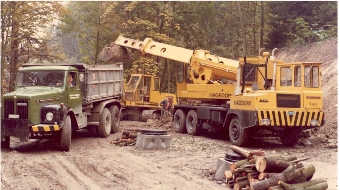
Gradall und 3-Achser LKW in den 70er-Jahren im Einsatz
