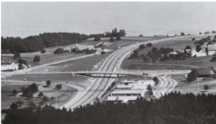
Nationalstrassenbau 1960 N3 in Wädenswil
