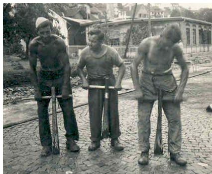
Pflastersteinbelag beim Einsanden und Stossen
