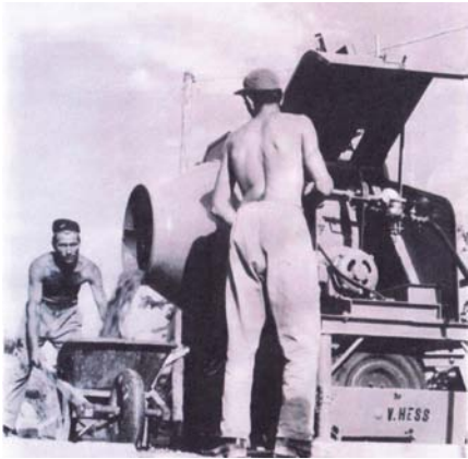
Betonmischen und Karrettentransport...
