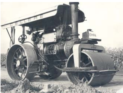
Dampfwalze beim Verdichten einer Fundamentalschicht im Strassenbau
