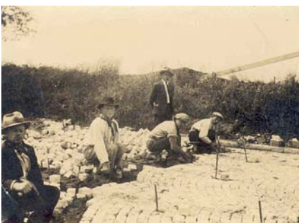
Vier Pflasterer und deren Chef beim Versetzen einer Bogenpflasterung als Strassenbelag
