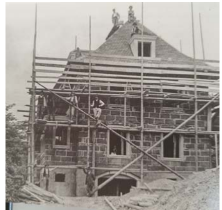
Gerüstbau für ein Einfamilienhaus in Rüschlikon
